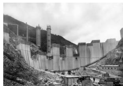
Figura 2. Otra perspectiva de la construcción de las torres de toma de captación de agua y de los diferentes bloques de hormigón de la presa de Susqueda (Fundación Endesa).
