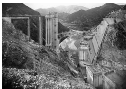
Figura 1. Construcción de las torres de toma de captación de agua y de los diferentes bloques de hormigón de la presa de Susqueda (Fundación Endesa).
