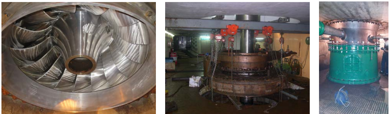
Trabajos de revisión mecánica en la zona de la turbina.
