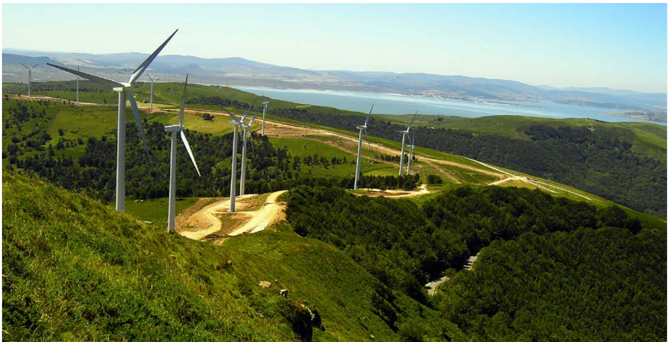
Parque eólico de Valdeporres (Burgos). Foto: Iberdrola.
