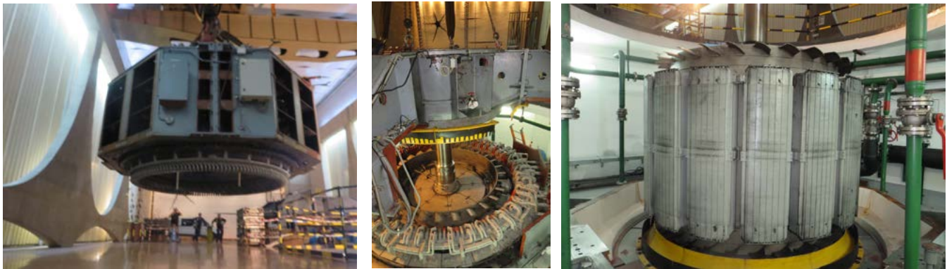
Trabajos de desmontaje grupos hidroeléctricos de Susqueda. Fuente: Base documental UPH Ebro Pirineos.
